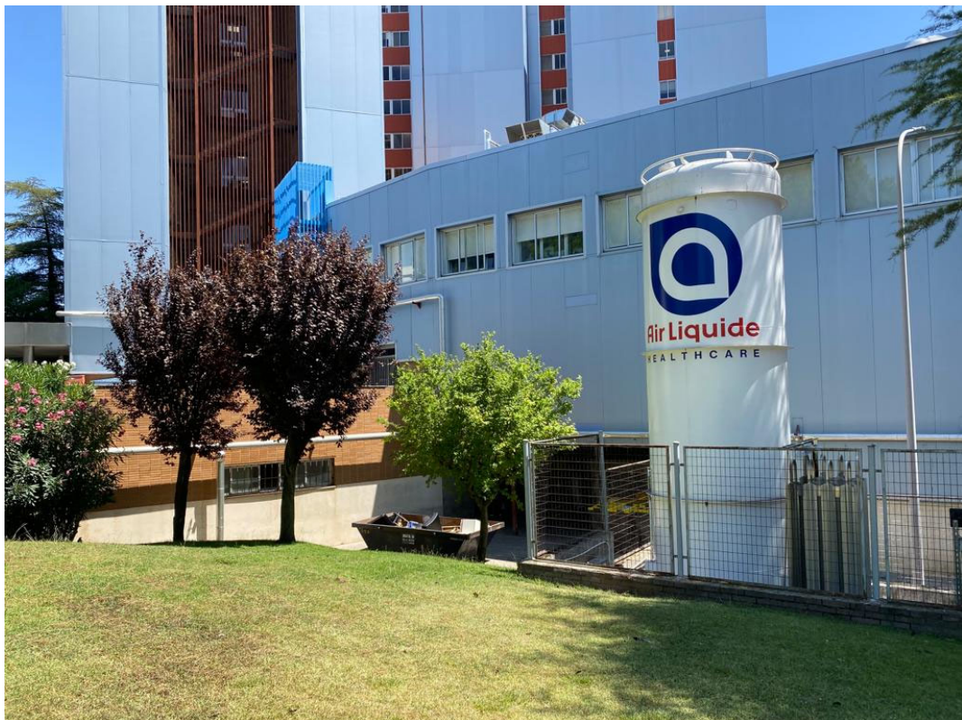
Vista del exterior frente a la actuación con dos depósitos de gases existentes
